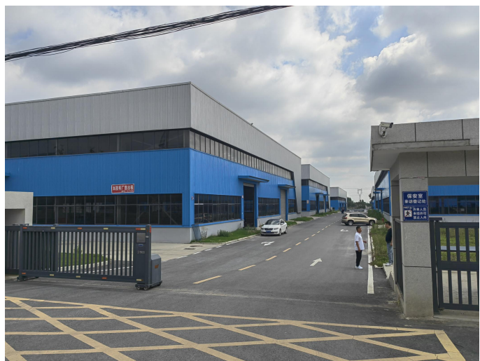
南阳市五得利再生资源服务有限公司院区大门及 拟迁建车间东侧道路
