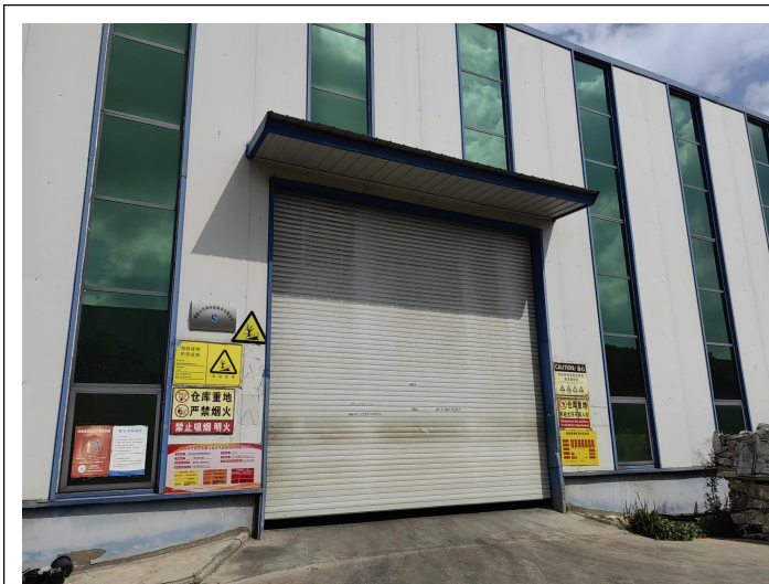
现有工程车间出入口
